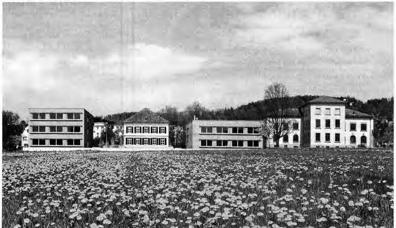
Harmonisch: Zwei kubische Bauten ergänzen die historischen Gebäude der Berufswahlschule Wetzikon.
