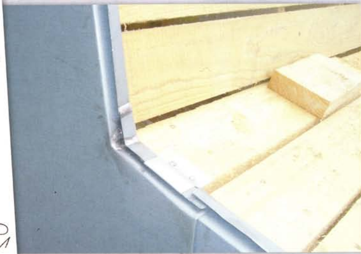
Ortganganschluss, vorbereitet zum Anschluss der Dachfläche
