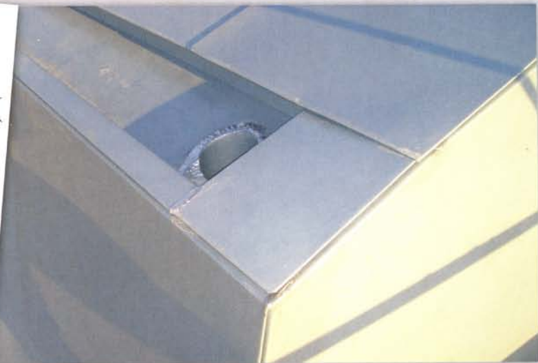
Eingelegte Dachrinne, Dachanschluss und Sichtblende
