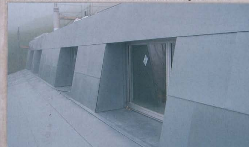
Zur optimalen Detailentwicklung arbeiteten Planer und Spenglerfachbetrieb Hand in Hand. Das Ergebnis: eine Rautendeckung aus blaugrau vorbewittertem Titanzink, die mit den betonierten Gebäudeteilen harmonisiert und dabei schlichte Eleganz vermittelt
