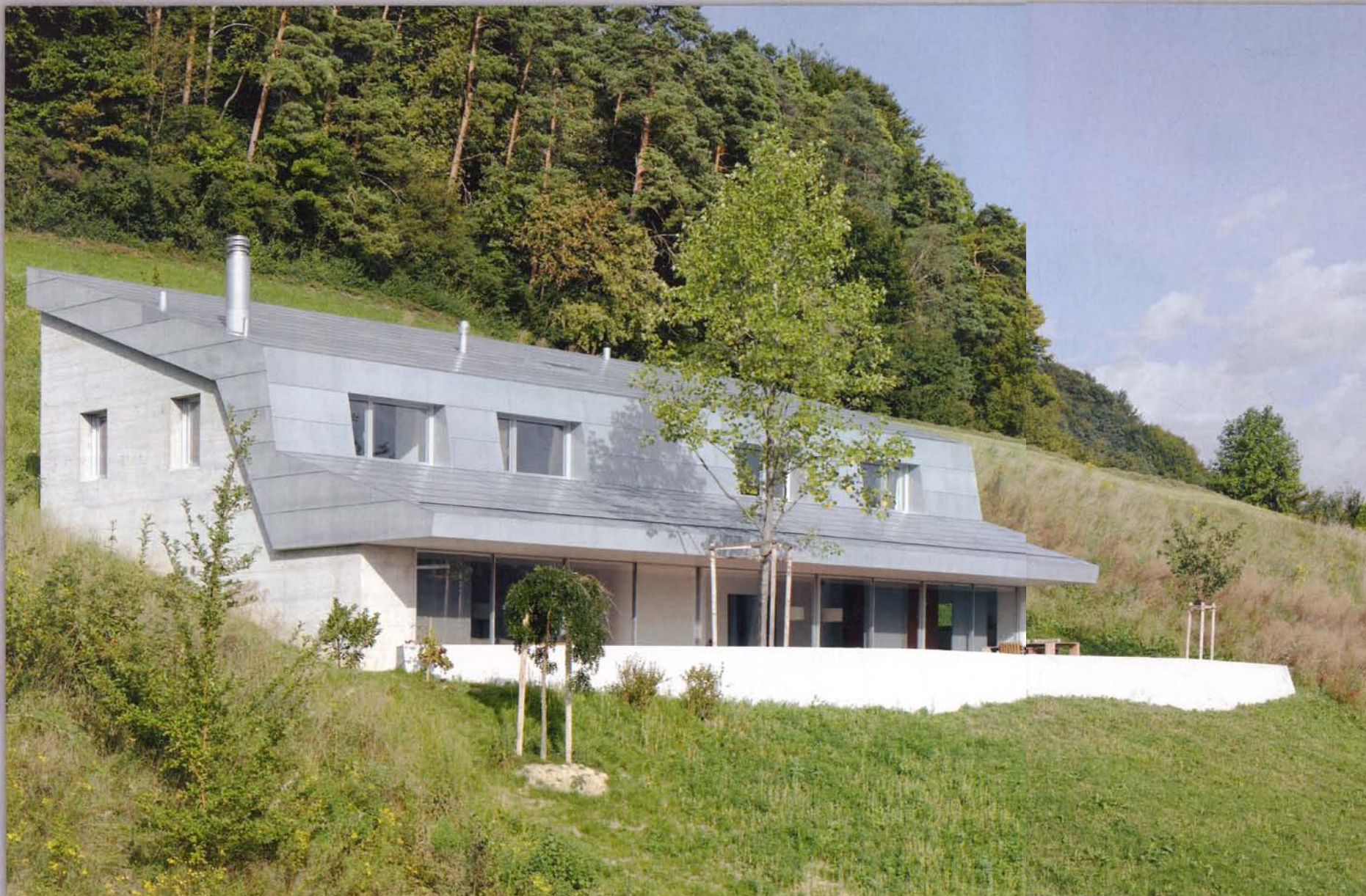
Zur optimalen Detailentwicklung arbeiteten Planer und Spenglerfachbetrieb Hand in Hand. Das Ergebnis: eine Rautendeckung aus blaugrau vorbewittertem Titanzink, die mit den betonierten Gebäudeteilen harmonisiert und dabei schlichte Eleganz vermittelt
