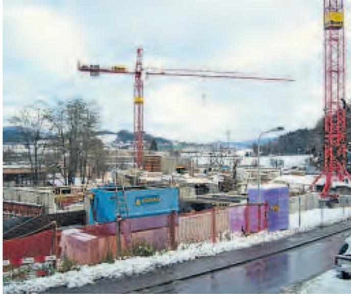
November 2008 – Noch bevor das Erdgeschoss erstellt ist, fällt der erste Schnee und sinken die Temperaturen. Aus Qualitätsgründen wurde die Sichtfassade bei Temperaturen unter 5 Grad nicht mehr betoniert.
