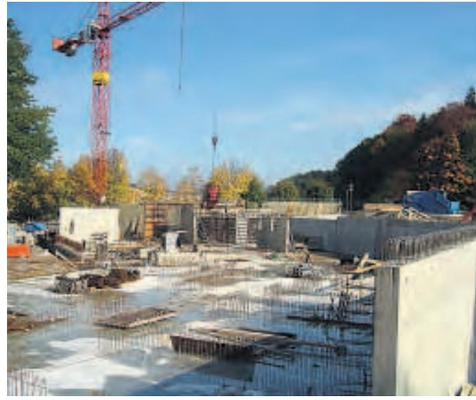
Oktober 2008 – Die Bodenplatte sowie einige Mauern des Sockelgeschosses sind betoniert. Um die Baukapazität zu erhöhen, wird mit zwei Kranen gleichzeitig gearbeitet.
